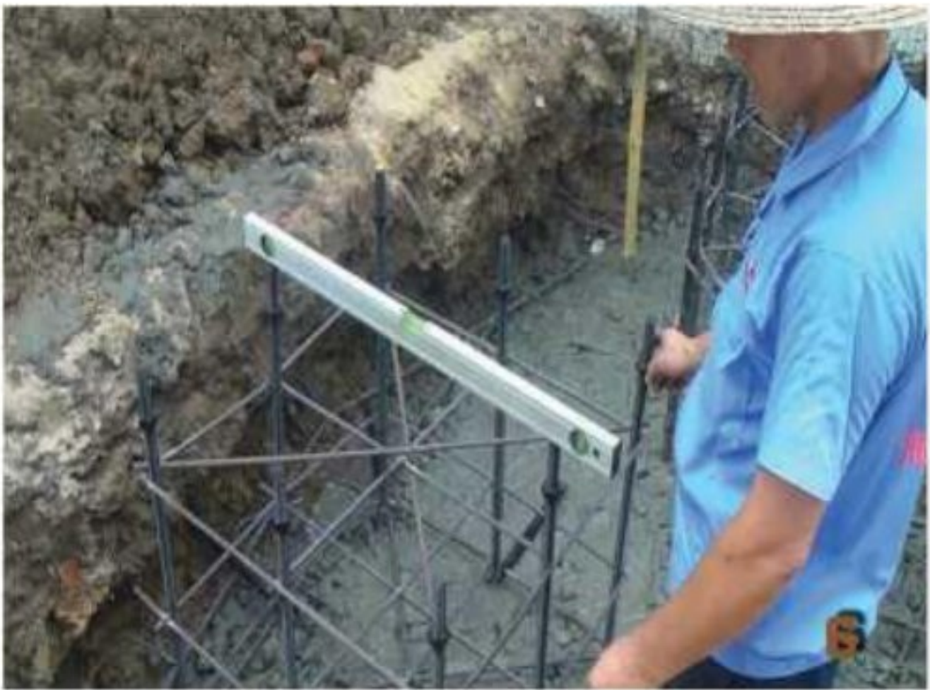
第一步：用钢筋+水泥先做混泥土地基。 Step 1: Make concrete foundation with steel and cement
