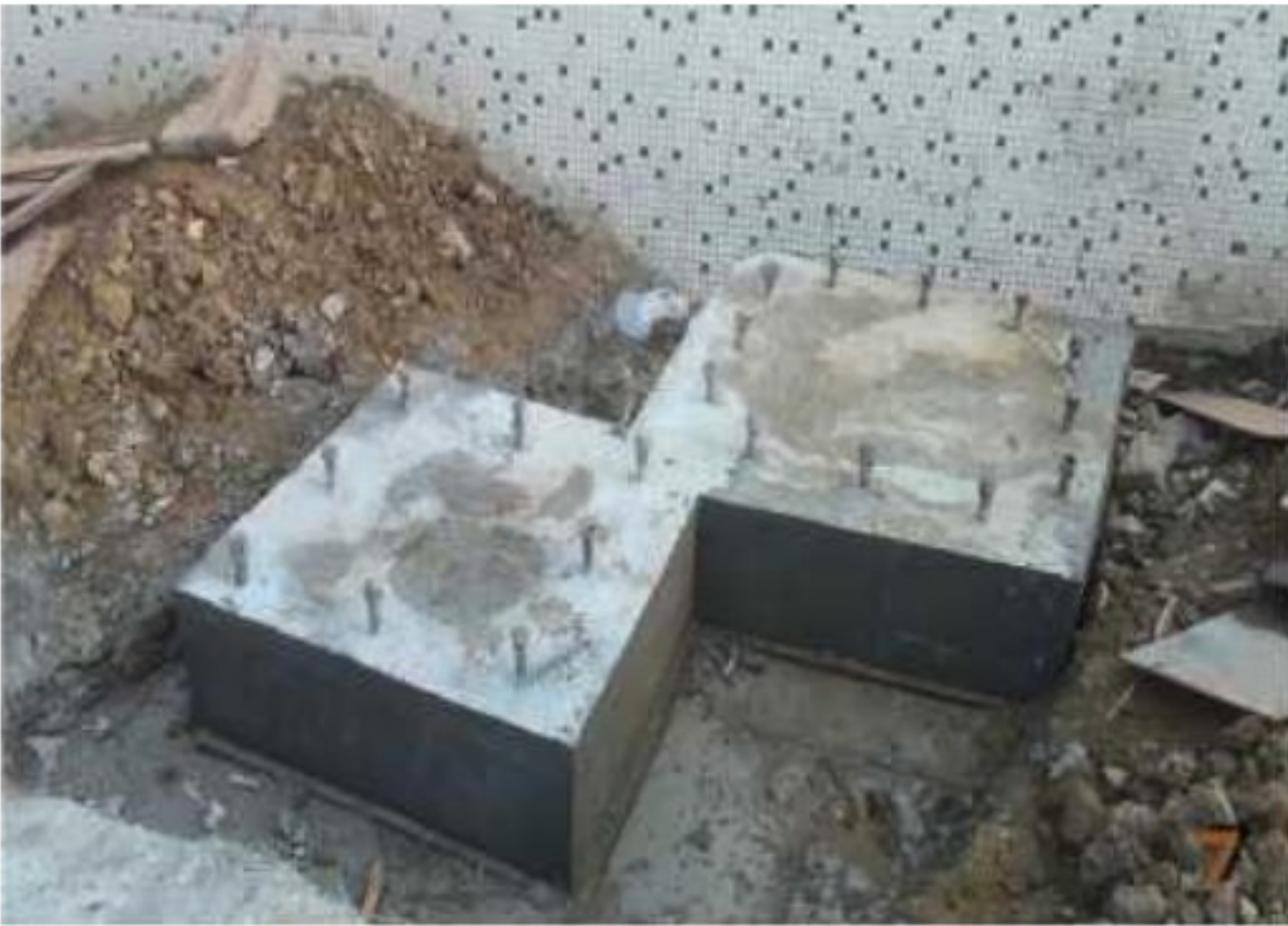
第一步：用钢筋+水泥先做混泥土地基。 Step 1: Make concrete foundation with steel and cement
