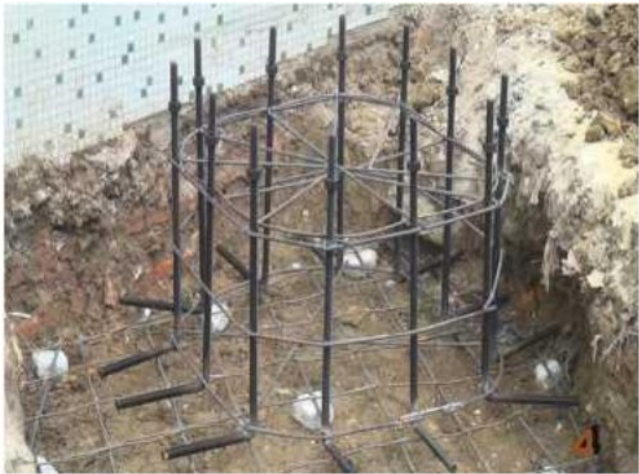
第一步：用钢筋+水泥先做混泥土地基。 Step 1: Make concrete foundation with steel and cement
